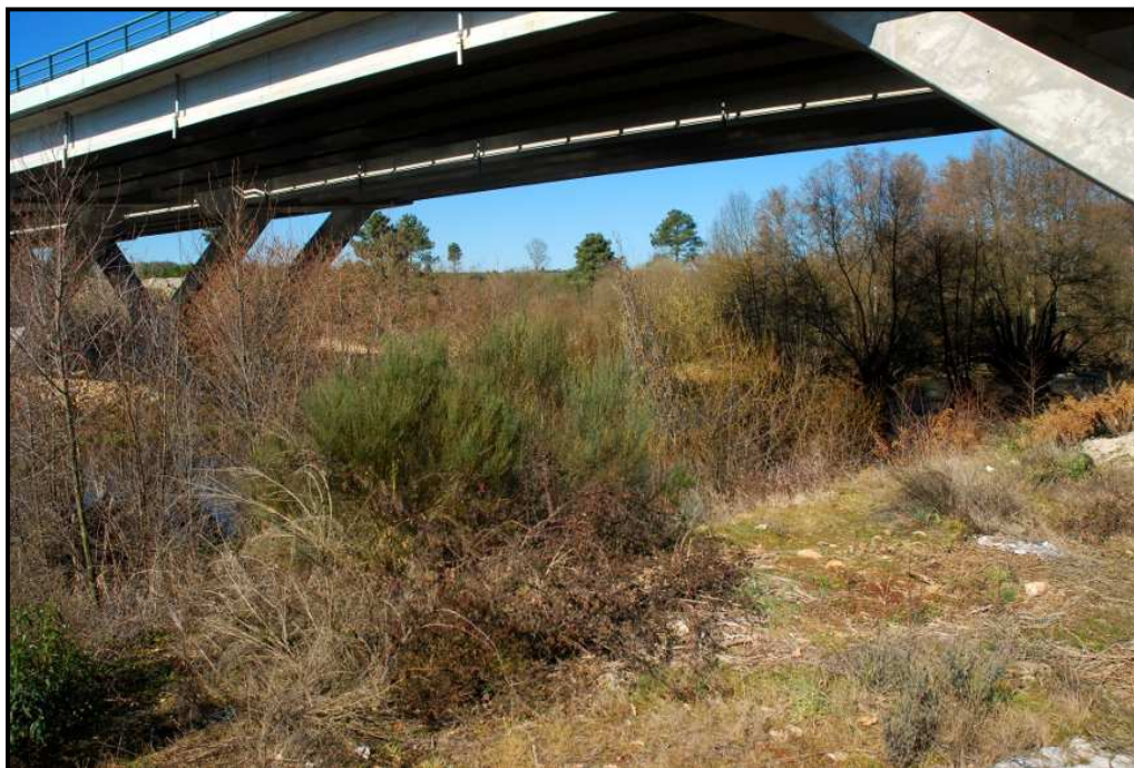
Figura 4.5 – Aspecto geral da galeria ripícola no ponto de amostragem P2.
