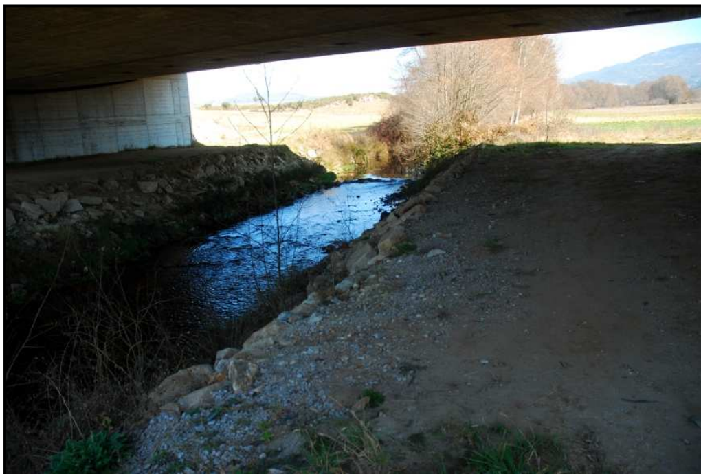
Figura 4.2 – Fragmentação da galeria ripícola sob o viaduto.
